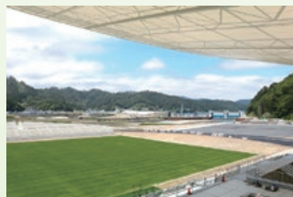
メインスタンドから見える大槌湾沿いでは防潮堤や鵜住居川の水門の工事が進んでいます。ワールドカップ開催時までには竣工予定です。
